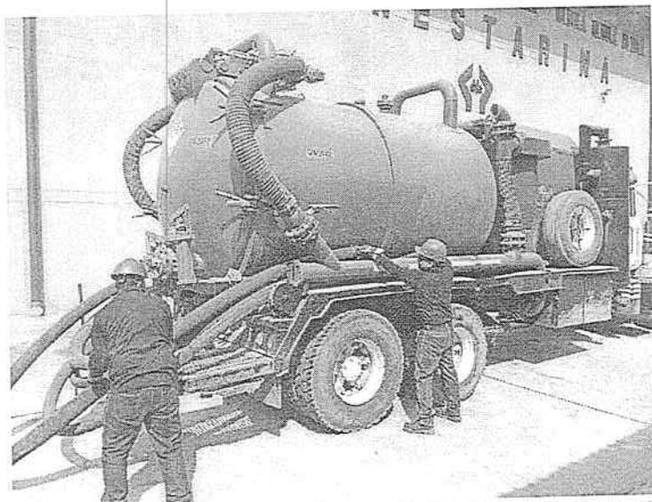
**Fotografía No. 1** *Camión VACTOR para realizar actividad de limpieza de poza séptica*
